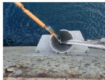
荷揚場シルトフェンス端部と 固定金具の接続状況
