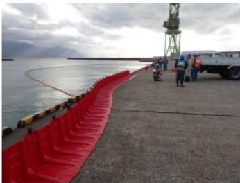
荷揚場シルトフェンス設置状況 (赤の遮水壁：ボックスウォール) (屋外 T.P. 3.0m)
