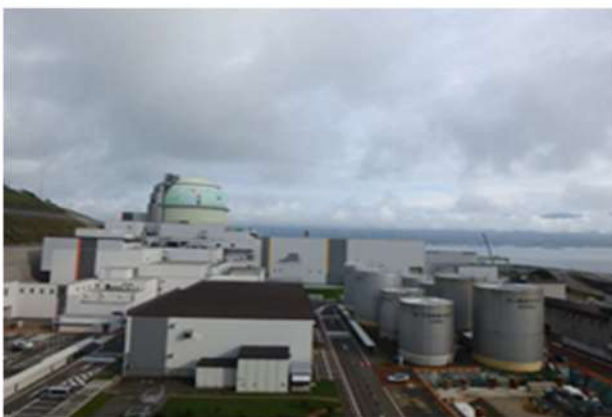
2号炉タービン建屋屋上
