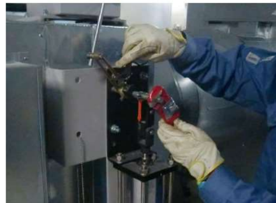
(空気作動ダンパ閉作業イメージ)
