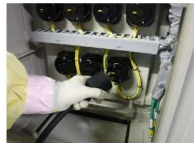
電源ケーブル接続 (原子炉建屋 T. P. 24. 8m)
