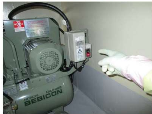
可搬型代替ガスサンプルリング圧縮装置起動 (原子炉建屋 T. P. 24. 8m)
