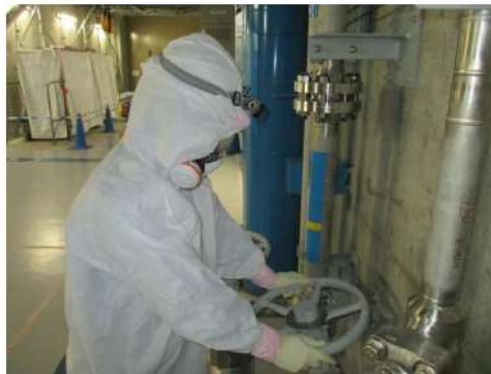
原子炉容器から原子炉格納容器への切り替え 系統構成 (原子炉建屋 T. P. 10. 3m)
