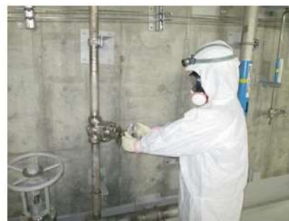
可搬型大型送水ポンプ車による原子炉格納容器下部への注水系統構成 （運転員（現場）C） （原子炉建屋 T.P. 10.3m）
