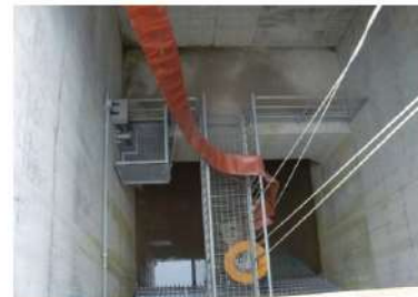
海水取水箇所への水中ポンプ設置 (屋外 T. P. 10. 3m)
