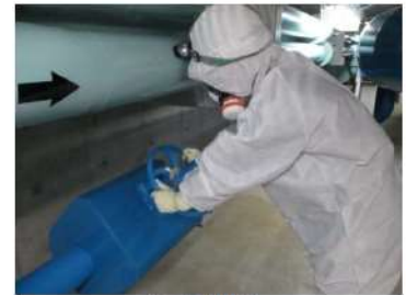
通水操作 (原子炉建屋 T. P. 2. 3m)
