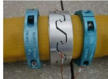
可搬型ホース（150A）接続後
