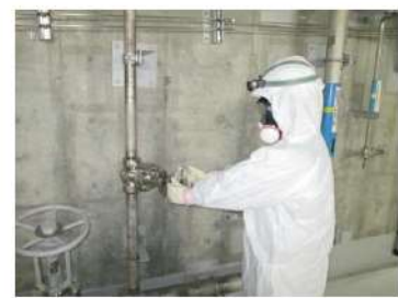
可搬型大型送水ポンプ車による 原子炉容器への注水 系統構成 （運転員（現場）C） （原子炉建屋 T.P. 10.3m）
