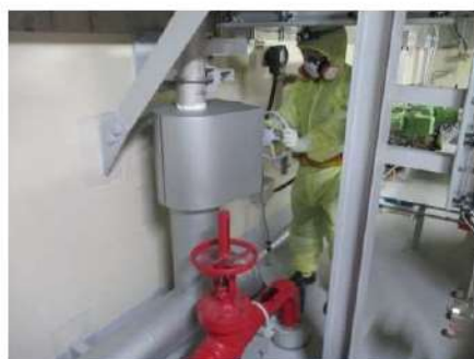
消火ポンプによる原子炉容器への注水系統構成 （運転員（現場）B） （原子炉補助建屋 T.P. 10. 3m）
