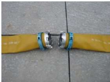
可搬型ホース（150A）接続前
