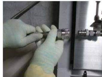
アニュラス全量排気弁等操作用可搬型窒素ガスボンベのカプラ接続 (原子炉建屋 T.P. 40.3m)
