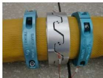
可搬型ホース（150A）接続後
