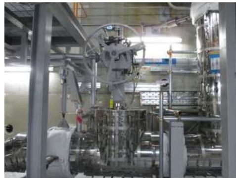
3 A-余熱除去ポンプ入口弁 (3V-RH-005A)
