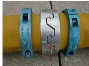
可搬型ホース（150A）接続後
