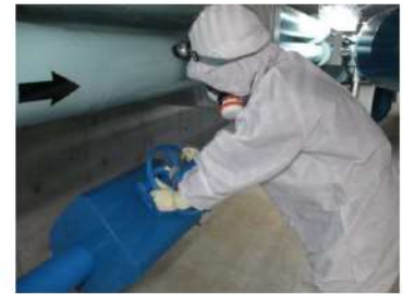
通水操作 (原子炉建屋 T.P. 2. 3m)
