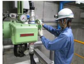
タービン動補助給水ポンプ 駆動蒸気入口弁「開」操作 （原子炉建屋 T. P. 14. 3m）
