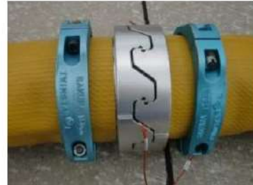
可搬型ホース (150A) 接続後
