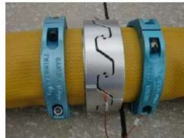
可搬型ホース (150A) 接続後
