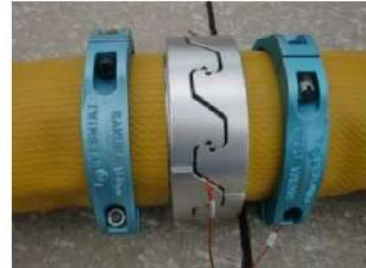
可搬型ホース (150A) 接続後
