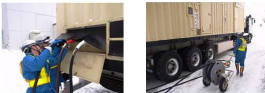
図2 可搬型代替電源車設置訓練
