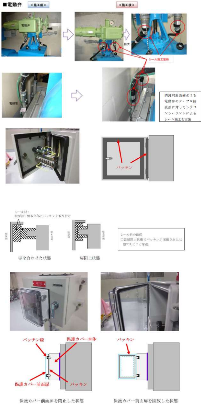
図2 現場での被水状況を考慮した被水対策について
