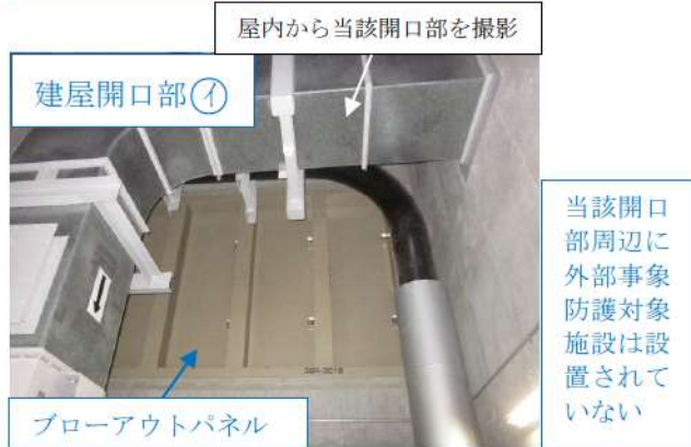
図4 泊発電所3号炉における建屋開口部周辺の屋内写真他 (T.P.17.8m (中間床含む)) (2/2)
