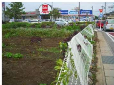
フェンスの変形
