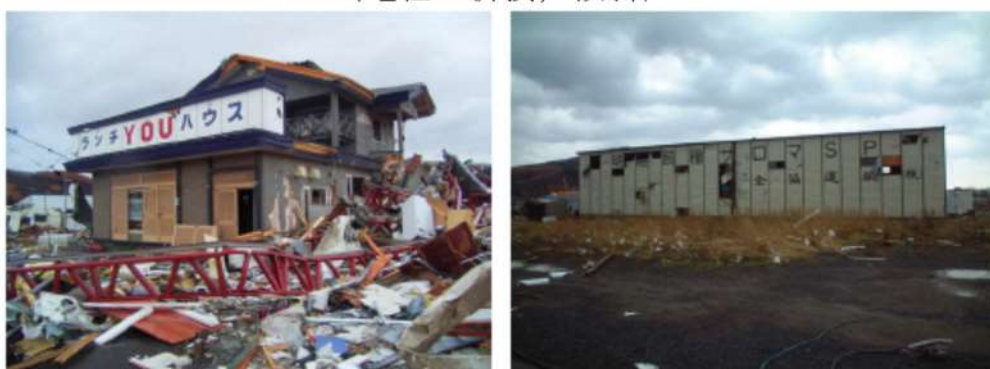
(建築物への飛来物の衝突痕)
