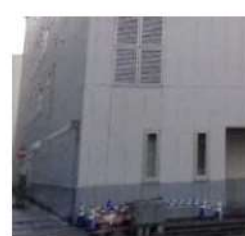
外壁 (セメント板)
