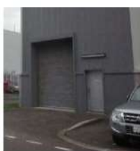
シャッター, 扉
