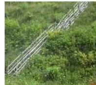
階段（単管パイプ製）
