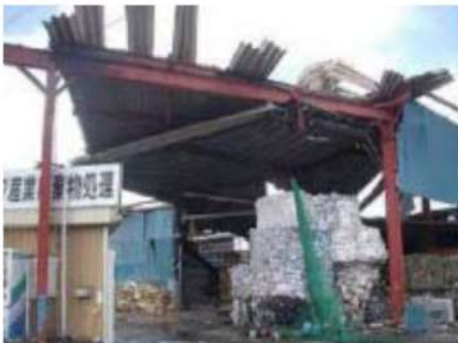
折板の損傷
