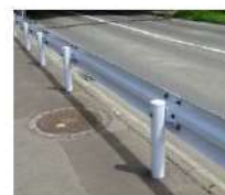
ガードレール
