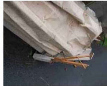
飛散した折板屋根の状況
