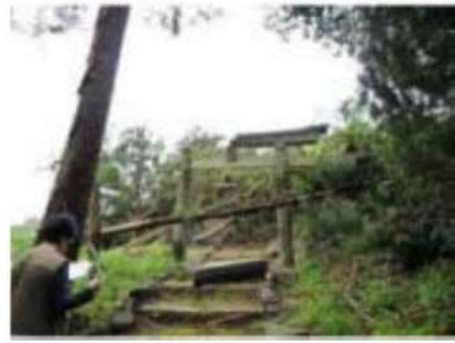
倒木の折損と鳥居の被害
