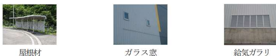
図 2 泊発電所において竜巻による風荷重や飛来物の影響を受けやすいと考えられる部位
