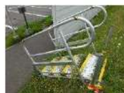
階段（単管パイプ製）
