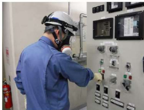
制御棒駆動装置用電源出力遮断器開放 （原子炉建屋 T. P. 17. 8m）
