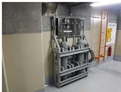
【図1 アニュラス全量排気弁操作用可搬型窒素ガスポンプ】
