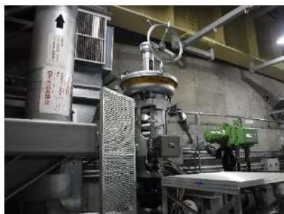
【図1 3B-主蒸気逃がし弁】
