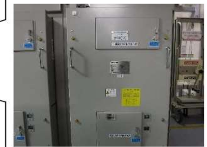
【図2 SA用代替電源受電B系 受電遮断器】
