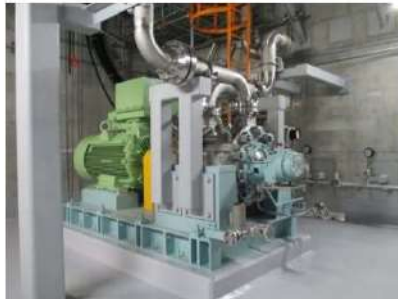
【図7 代替格納容器スプレイポンプ】
