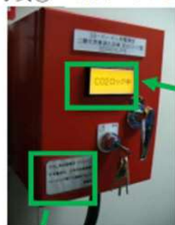
写真③ 放出ロック盤
