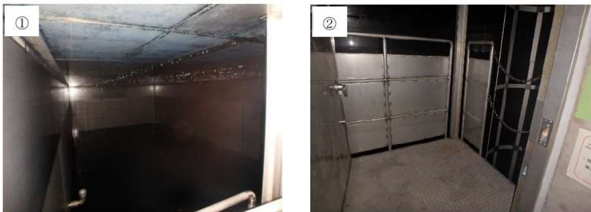
第 41-4-7 図：補助給水ピットの現場状況
