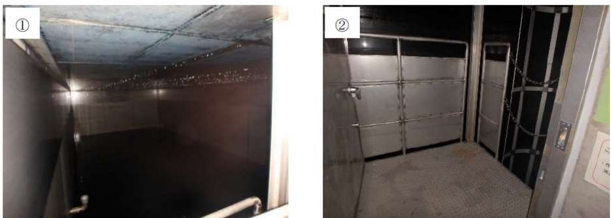
第 5-7 図：補助給水ピットの現場状況
