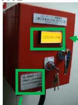
写真③ 放出ロック盤
