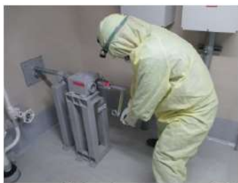
アニュラス排気ダンパ現場手動操作 (原子炉補助建屋 T.P. 40.3m)
