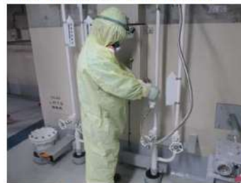
窒素供給操作(系統側バルブ操作) (原子炉補助建屋 T.P. 40.3m)
