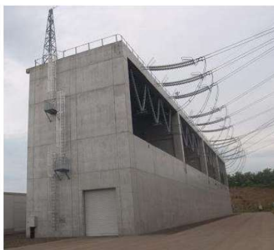
図1 開閉所（遮風建屋）
