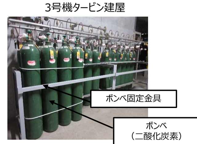
図17 発電所におけるボンベの設置状況
