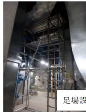
第2.1.4.10図 中央制御室非常用循環系統における足場設置困難箇所及び足場設置モックアップ実施結果
