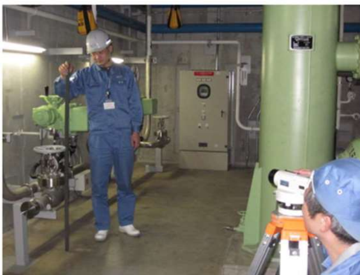
別紙 1-図 1 弁類（制御用空気Cヘッド供給弁）
