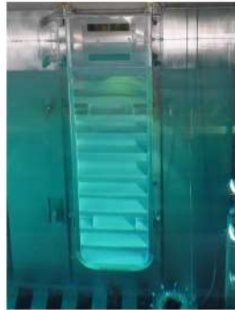
ゲートの設置状況
