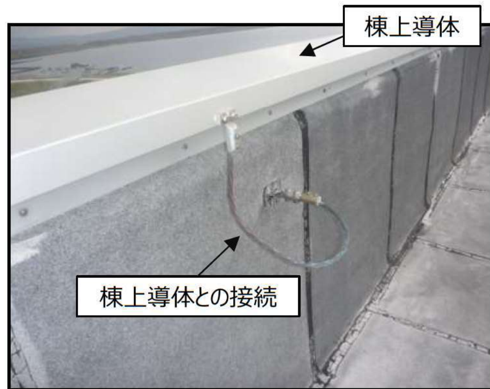
循環水ポンプ建屋
