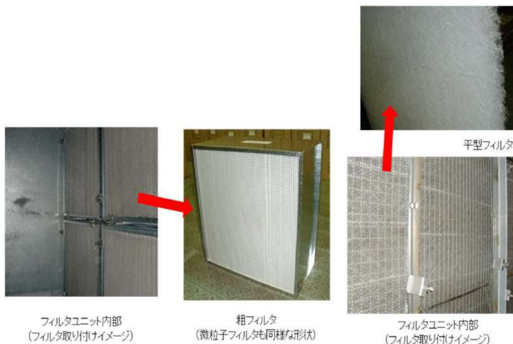
換気空調設備のフィルタ設置状況
