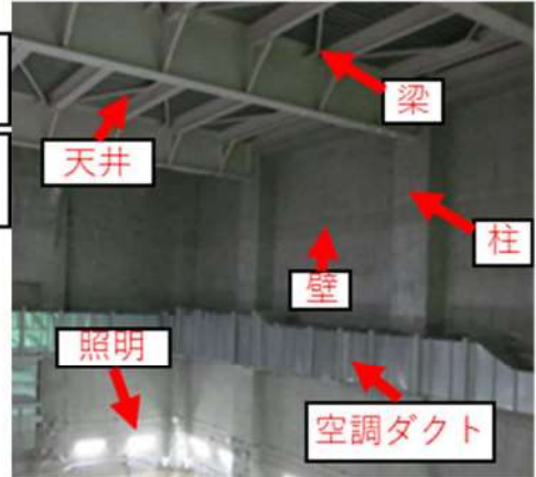
②使用済燃料ピット上部
