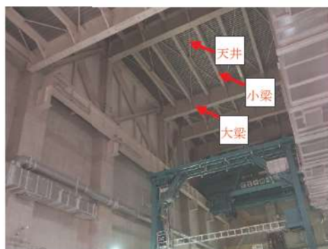
図 5.2.2 燃料取扱棟の屋根
