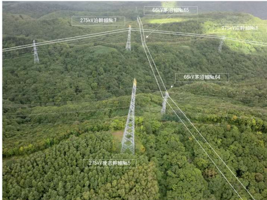
第 2. 2. 3. 5 図 ③交差箇所の現地状況 (1/3)
