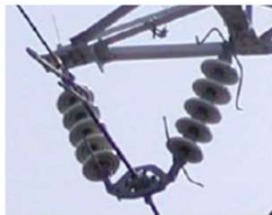
第2.2.4.8図 懸垂碍子化の施工状況
