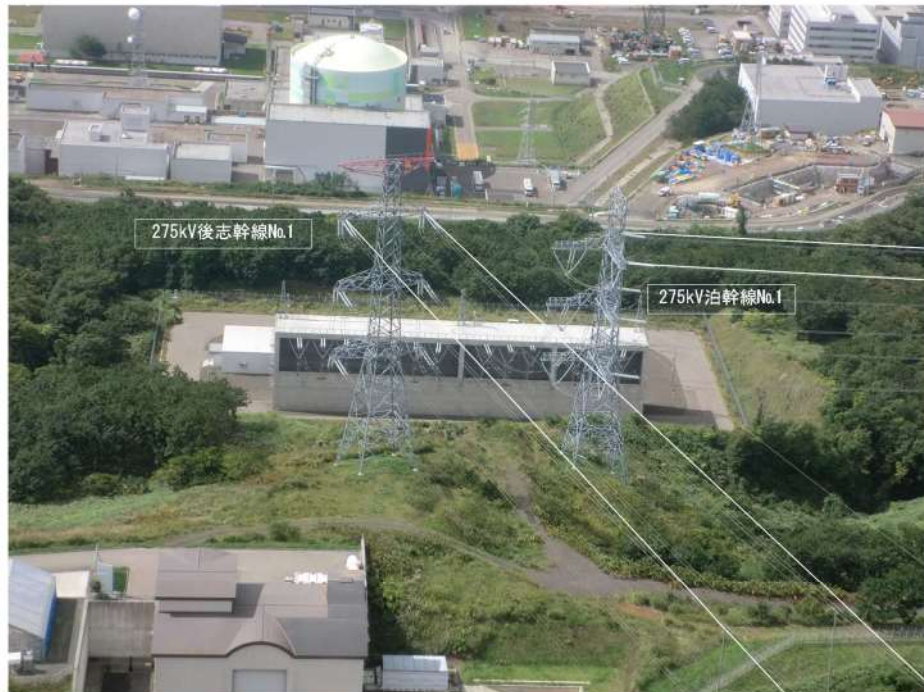
第 2.2.3.3 図 ①近接箇所の現地状況 (1/3)
