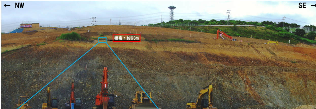
平成25年度造成工事時 露頭写真 (e地点)
