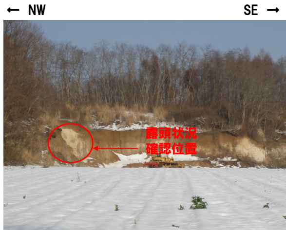
露頭①全景 (底盤標高:約20m, 上面標高:約35m)
