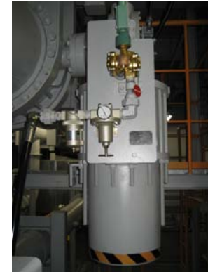
⑦アニュラス空気浄化ファンダンパ (原子炉建屋 T. P40. 3m)
