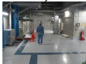
②6インチフレキシブルホース 10.0m 接続箇所 2箇所 (原子炉建屋T. P. 10. 3m)
