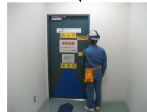
③A-F階段入口扉へ
