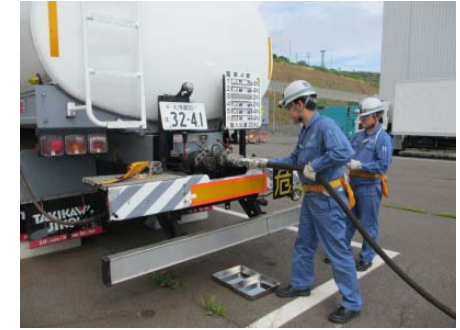
②タンクローリーへ 給油ホースの接続
