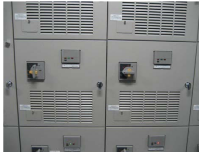
③440Vパワーコントロールセンタ (左側:NFB入状態、右側:NFB切状態)
