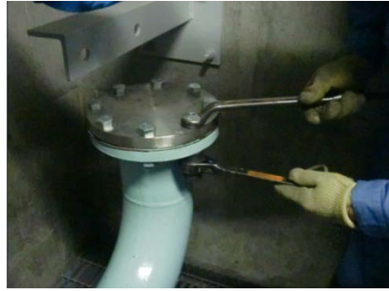
閉止フランジの取り外し(写真: SWS側閉止フランジの取り外し)
