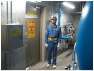
④補助建屋給気空調機械室からR-B階段入口扉へ
