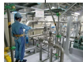
③6インチフレキシブルホース 5.5m 接続箇所 2箇所 (原子炉建屋T. P. 24. 8m)
