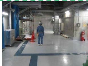
①代替格納容器スプレイポンプエリア(設置予定場所)
