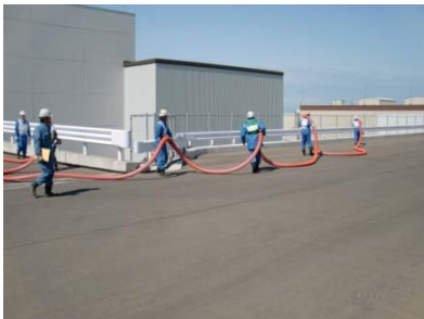
31m盤ホース敷設状況 (カップラタイプではあるが、消 防ホースではない)
