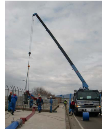
水中ポンプ吊り下ろし作業
