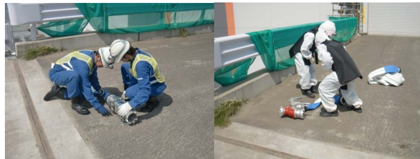
Step No. 5-a-3 ホース敷設(屋外)
