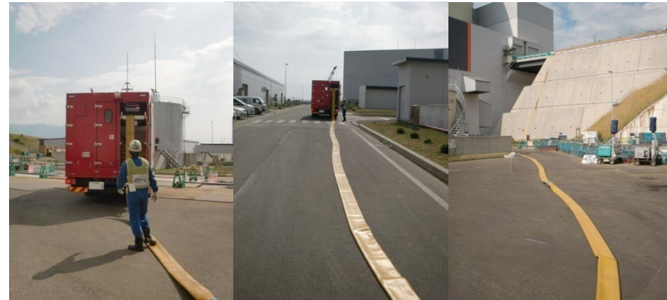
ホース延長・回収車 により法面から スクリーン室方面へ 敷設されたホース
