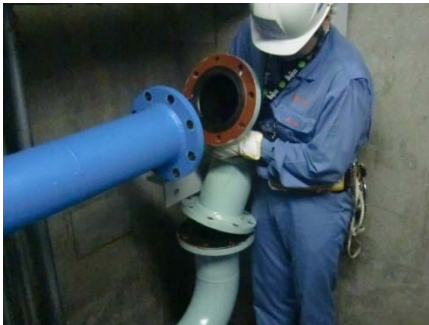
スプールピースの取り付け
