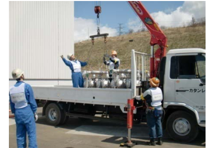
空気作動式ポンプ吊り下 ろし作業
