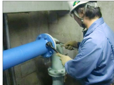
スプールピースの締め付け
