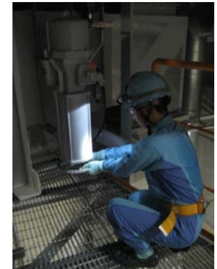
⑧アニュラス空気浄化ファンダンパ (原子炉建屋 T. P. +33. 1m)
