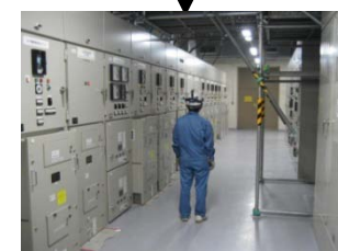
⑥安全補機開閉室から原子炉建屋への境界扉へ
