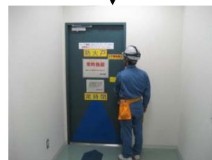
③A-F階段入口扉へ
