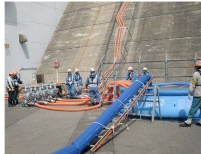
水槽及び空気作動式ポン プ組立状況
