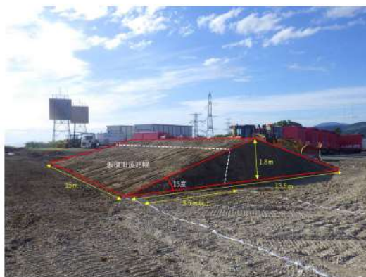
第3図 斜面崩壊後を模擬した土砂
