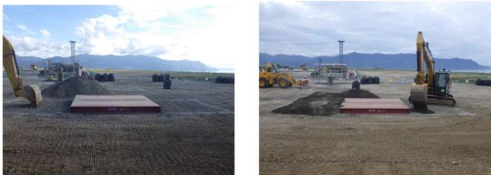
第10図 段差復旧状況
