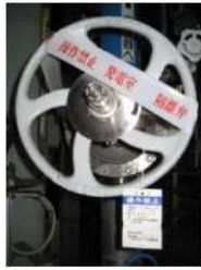
操作禁止タグ タグによる識別
