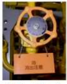
油類に係る弁 弁の識別
