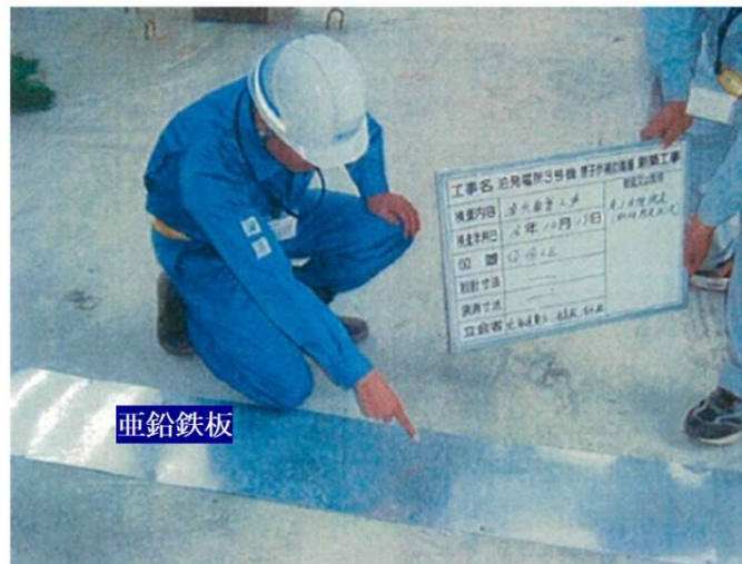
添付8-3図 集水管敷設状況写真(泊3号炉建設時)
