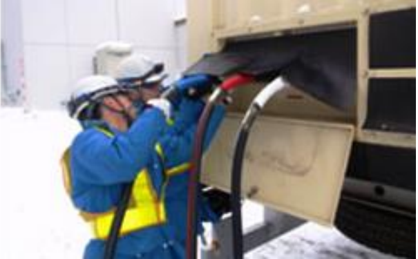
③代替給電訓練 交流電源喪失を想定し、可搬型代替電源車を起動し、受電設備へ接続する訓練
