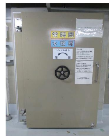
水密扉の設置状況
