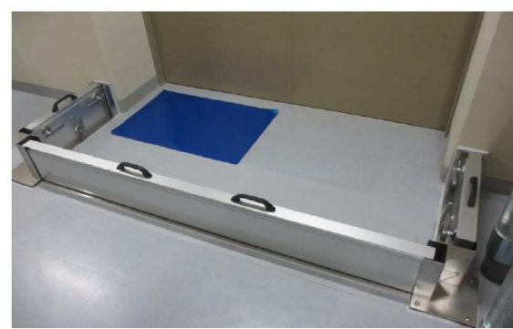
止水板の設置状況
