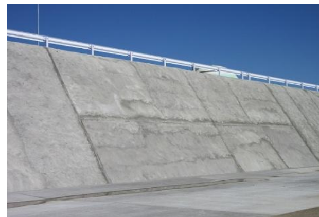
防潮堤(約1,000m)
