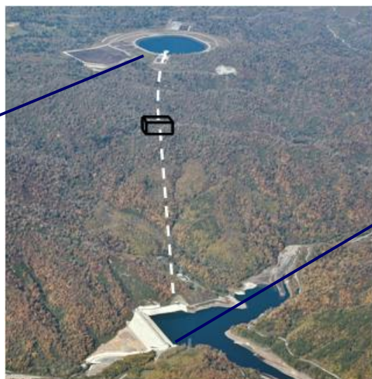
京極発電所全景
