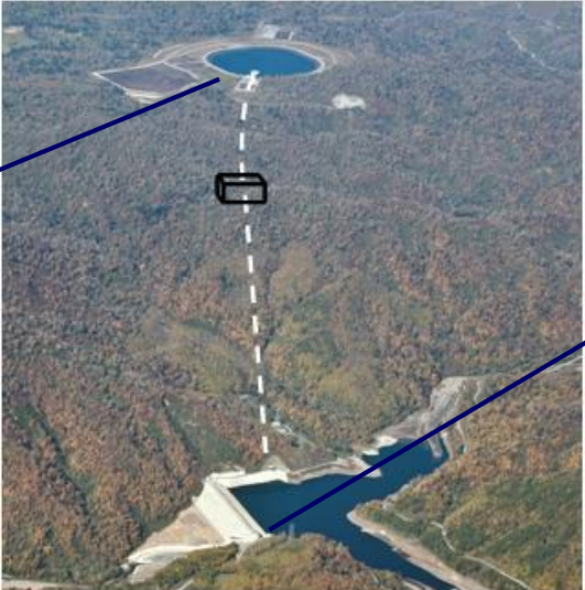
京極発電所全景
