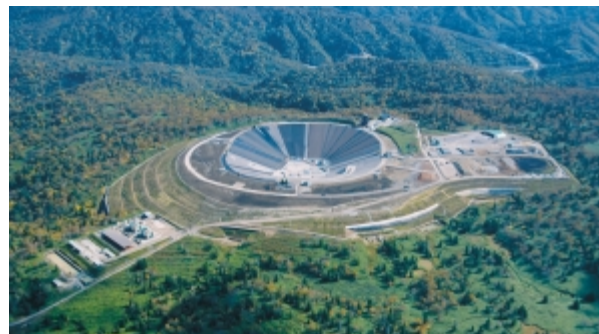
京極水力発電所建設工事(上部調整池)
