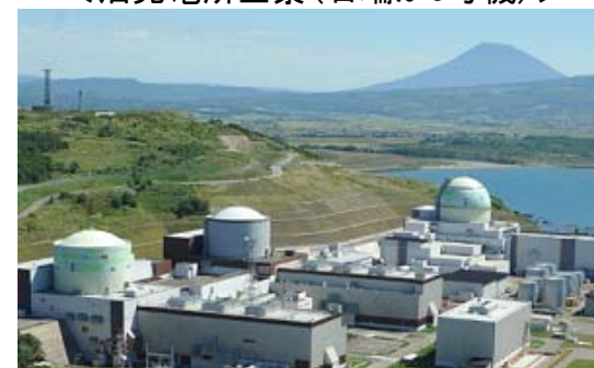
<泊発電所全景(右端が3号機)>
