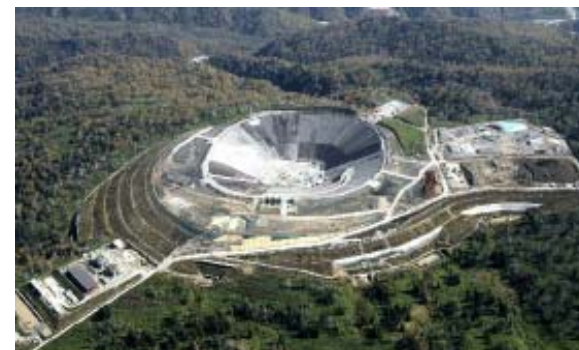
<京極発電所（上部調整池）>
