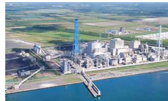
<苫東厚真発電所>
