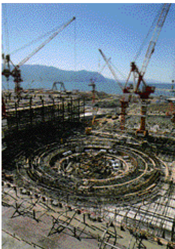
原子炉建屋の基礎を岩盤にしっかり固定
