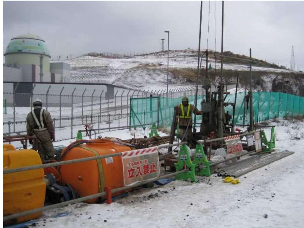
発電所敷地前面（堀株側）ボーリング状況
