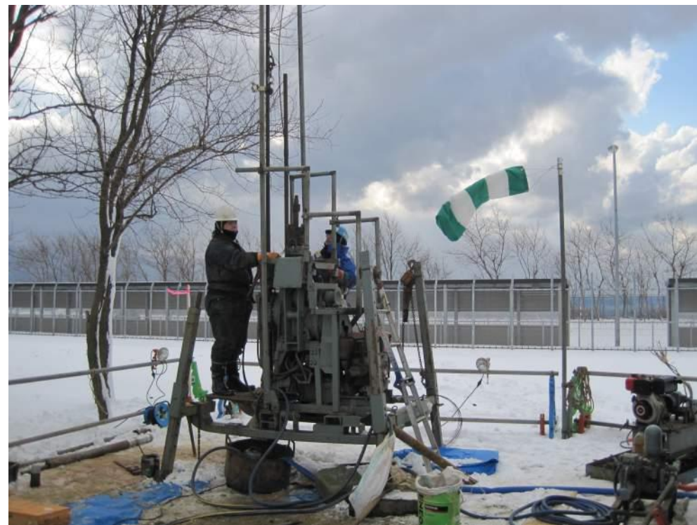
発電所敷地前面（中央部）ボーリング状況
